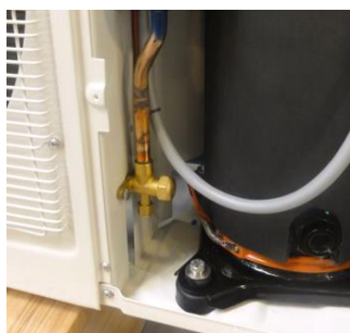
Рис 26: Сервисный порт на жидкостном трубопроводе
