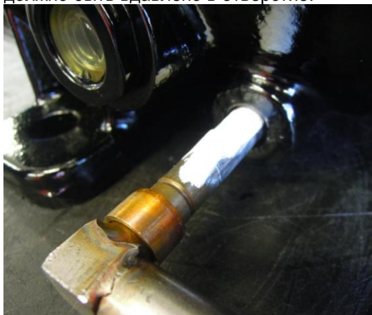
Рис. 28: Процедура установки нагревателя картера
