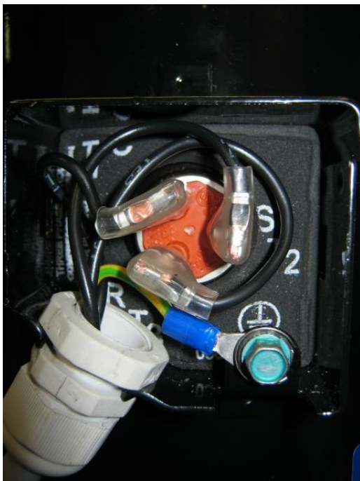
Рис. 12: Правильное подключение клеммной коробки IP21 с использованием кабельной муфты, ZH04K1P
